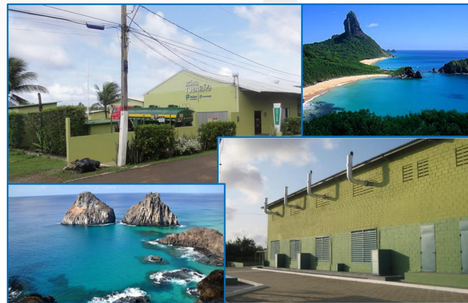
UTE Tubarão (4.759 kW) – Fernando de Noronha
